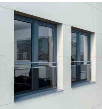
Als kombinierte Variante mit Stange und Glas bilden Absturzsicherungen ein Highlight in der Fassadenansicht
