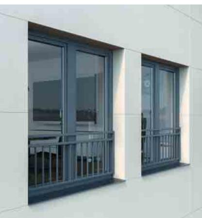
Die vertikale Aluminium-Stangenabsturzsicherung verschmilzt dank der Beschichtungsoption Ton-in-Ton zu einer optischen Einheit
