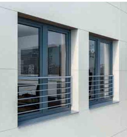
Individuelle Akzente setzen mit der horizontalen Edelstahl-Stangenvariante der Schüco Absturzsicherungen
